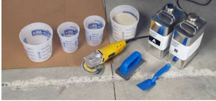
Use presentación galón para reparaciones de grietas de 20 mm de ancho en adelante.
